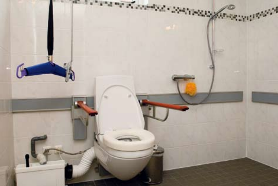
Boven: het toilet is mechanisch in hoogte verstelbaar. Rechts: bijna alles in de zorgkamer is op afstand te bedienen. Geheel rechts: het douche/föhn-toilet.
